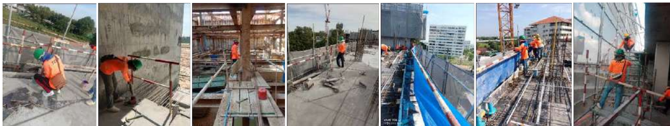
ตรวจสอบอุปกรณ์ยึดเกาะยึดโยงงานติดตั้งผนังสำเร็จ(Precast Concrete)
